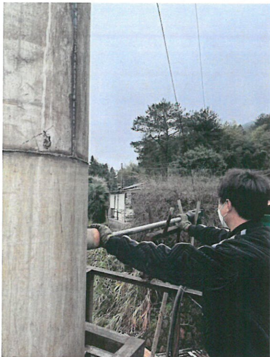
锅炉废气排气筒出口(FQPK-0001)G1
