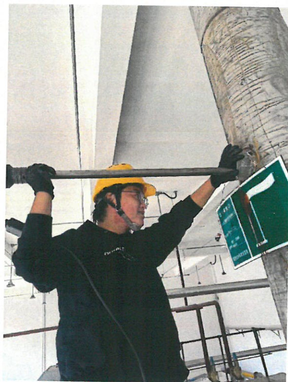
锅炉废气排放口 2# (FQ-21282) G3
