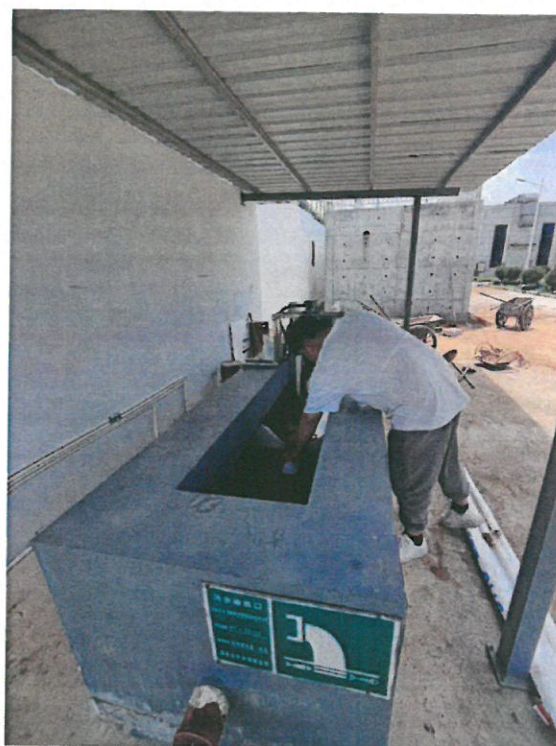
废水排放口 W1
