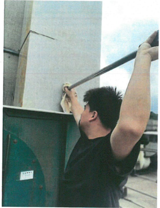
工艺有机废气排气筒出口(FQPK-0004)G4
