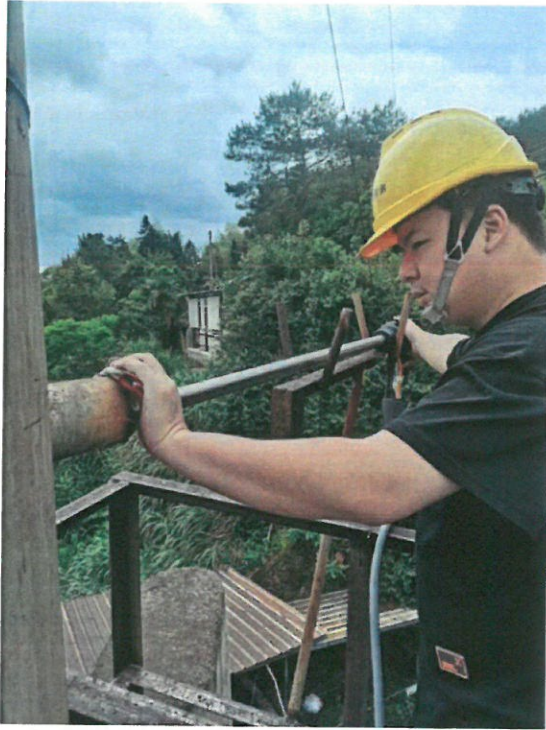
锅炉废气排气筒出口(FQPK-0001)G1
