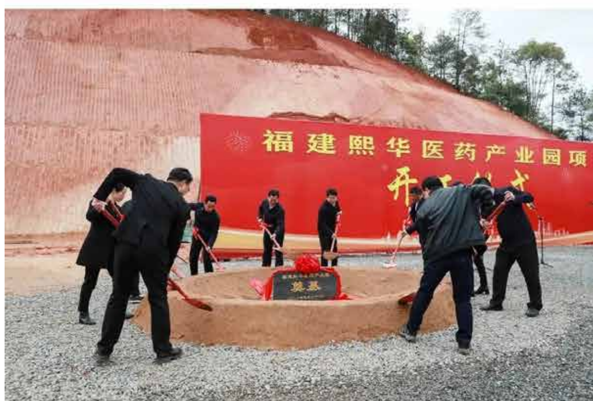
▲明溪县领导和熙翔制药企业负责人共同为项目奠基
