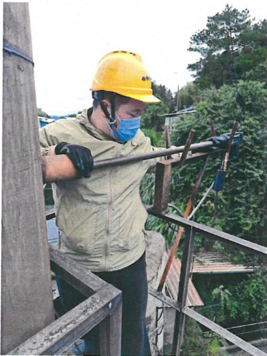
锅炉废气排气筒出口(FQPK-0001)G1
